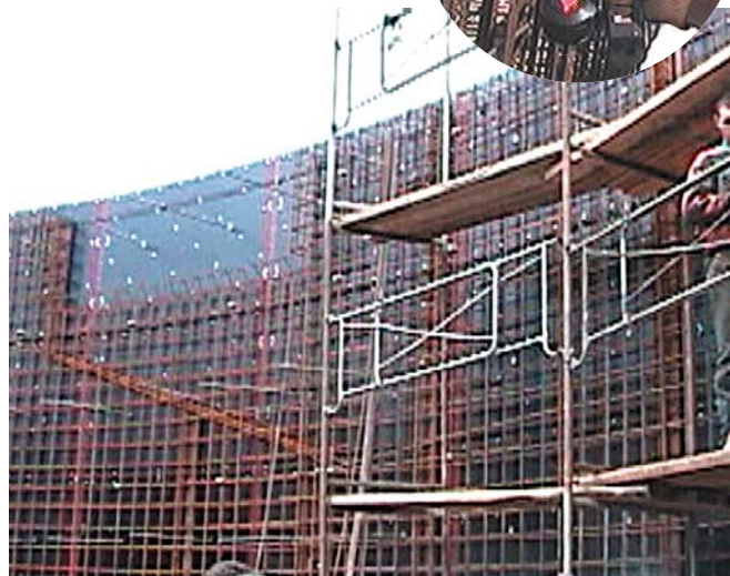
Santiere de constructii
